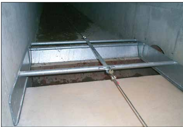
▲ Unterflurkanal mit Schieber am Abwurf
