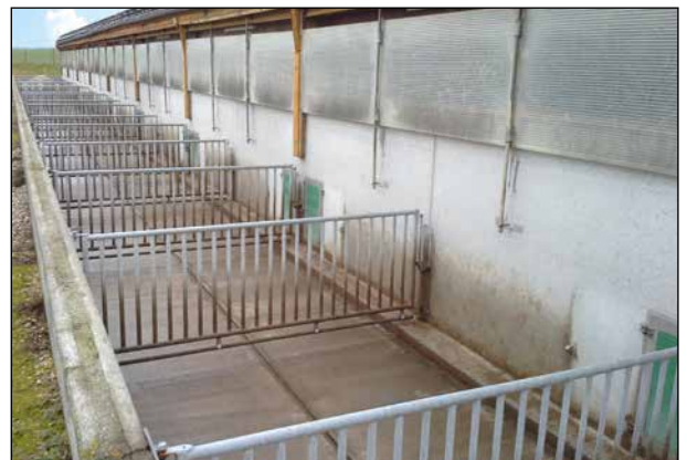
▲ Schieberanlage für den Auslauf
