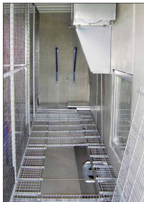
▲ Personalgang mit Wartungsöffnung
