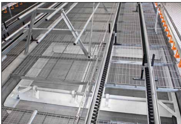
▲ Dungklappschieber unter Rost
