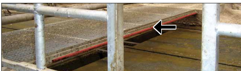
◀ Sicherheits-Schaltleiste (rot markiert)
