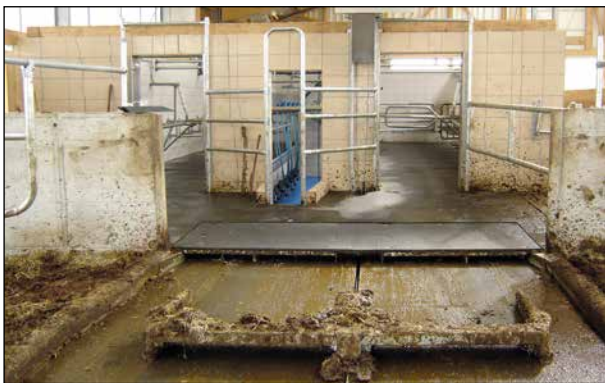
▲ Klappbare Querkanalabdeckung vor dem Melkstand
