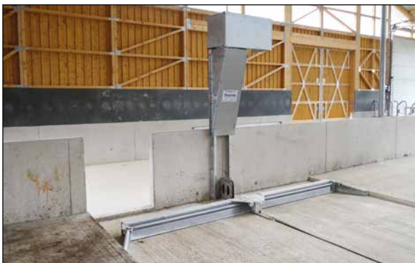
▲ Montage Antriebswinde EW4 mit Wandkonsole
