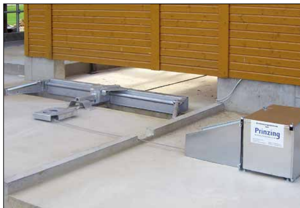
▲ Montage EW4, Umlenkrolle und PKSF
